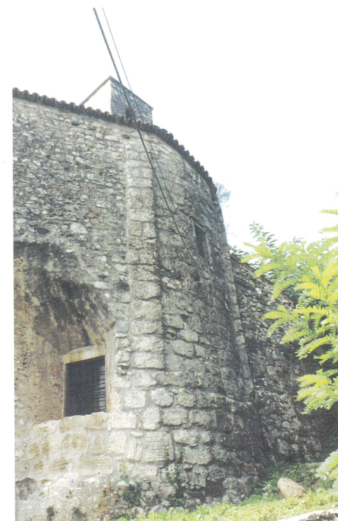
Oratorio di S. Salvatore in Montecchia di Crosara, la spessa muratura ricurva della cripta a levante può costituire la traccia dell'antico delubro. (Ph Centomo)
