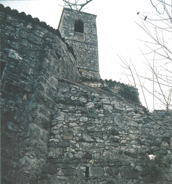
Prospetto est: zona delle absidi; particolari della complessa tessitura muraria
